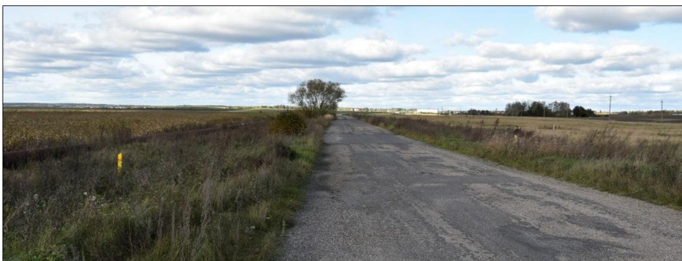
Рисунок 2.17 – Пересечение МГ с автодорогой Петровичи – подъезд к М-4
