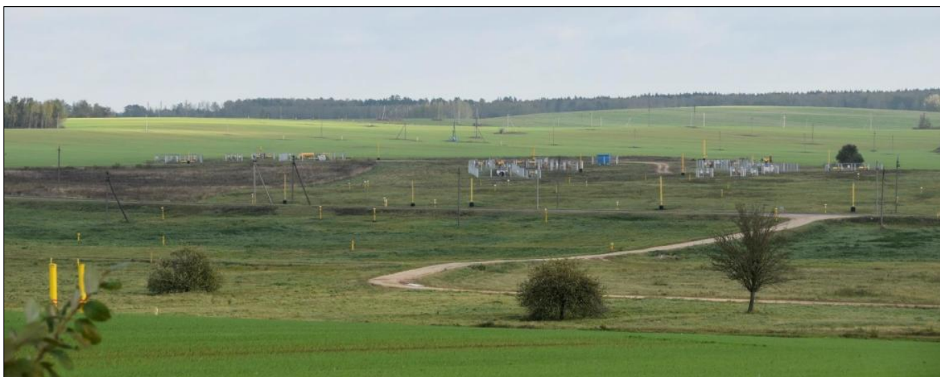
Рисунок 2.24 – Существующее состояние участка МГ (конечный отрезок км 651) в районе КС «Минск»
