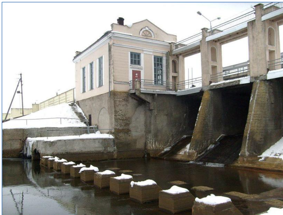
Рисунок 3.2 – Тетеринская ГЭС на реке Друть
